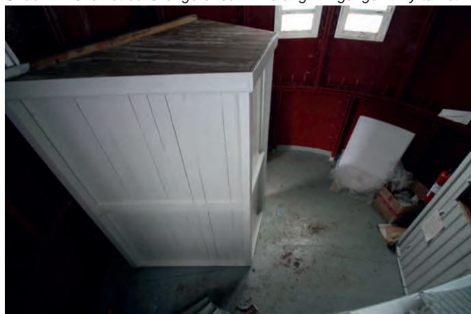
Under: En snekret boks fungerer som vindfang i inngangen til fyrtårnet.
